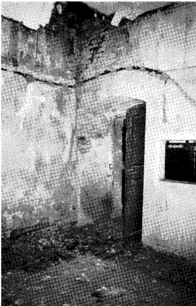
Die Sakristei wird als nächster Bauabschnitt in Angriff genommen.
