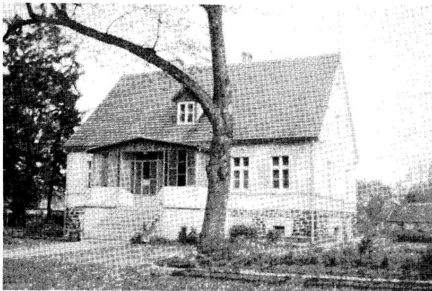
Pfarrhaus in Chojnik. 1986, die Glasveranda wurde in der Amtszeit des kath. Pfarrers Wawrzyniak angelegt.
