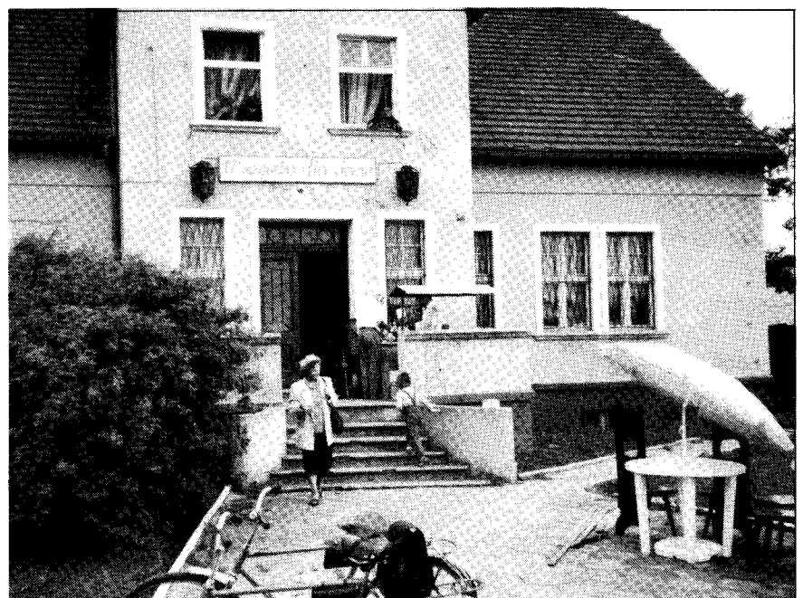
Das frühere Gutshaus der Familie Mendrzyk in Neuhofer. In der „Diele“ hat sich ein „Kramladen“ breit gemacht. Auf der Terrasse, vor dem Haus, ein Verkaufsstand für Getränke aller Art, der immer gut besucht war.
