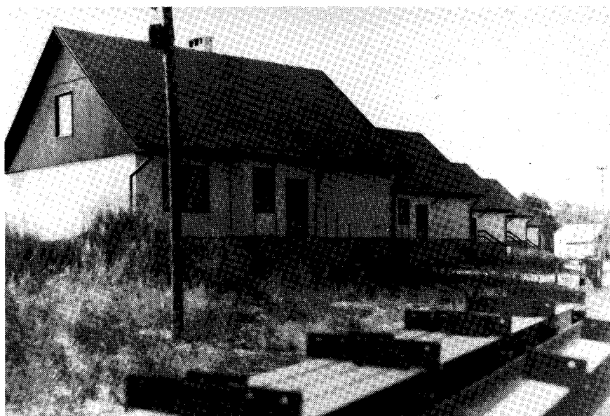
Die neuerbauten Häuser am Ende der Walkerstraße. Sie warten noch auf den Einzug der neuen Besitzer
