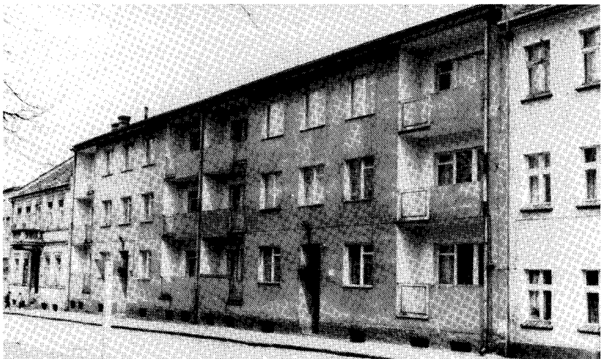
Das erste nach 1945 an Stelle der dort zerstörten Wohnhäuser neu gebaute Haus am Ring.
