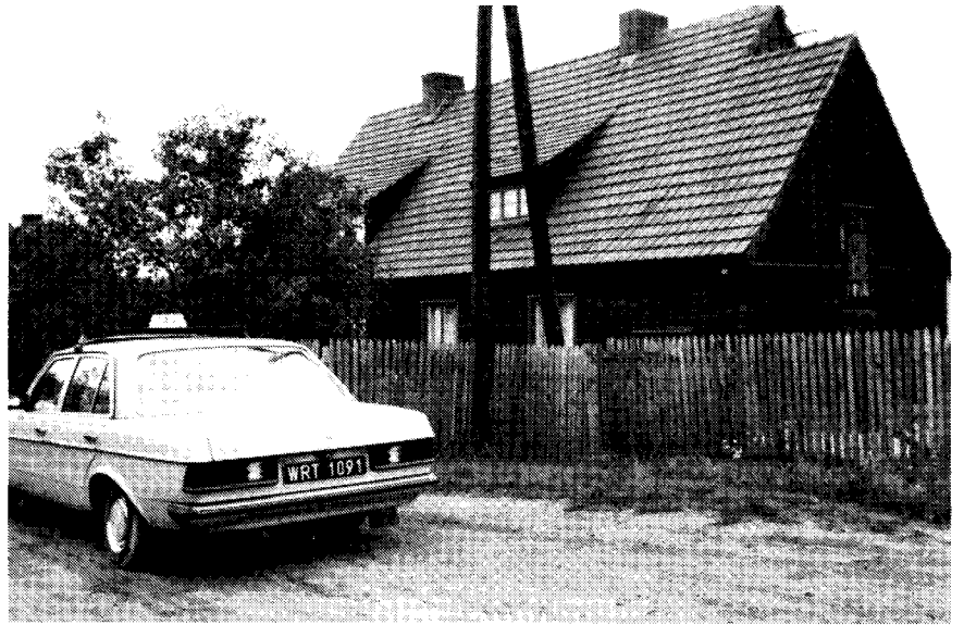
Eins der gut erhaltenen Häuser in der „Neger-Siedlung“ in Festenberg. Erbaut in den 30er Jahren.
