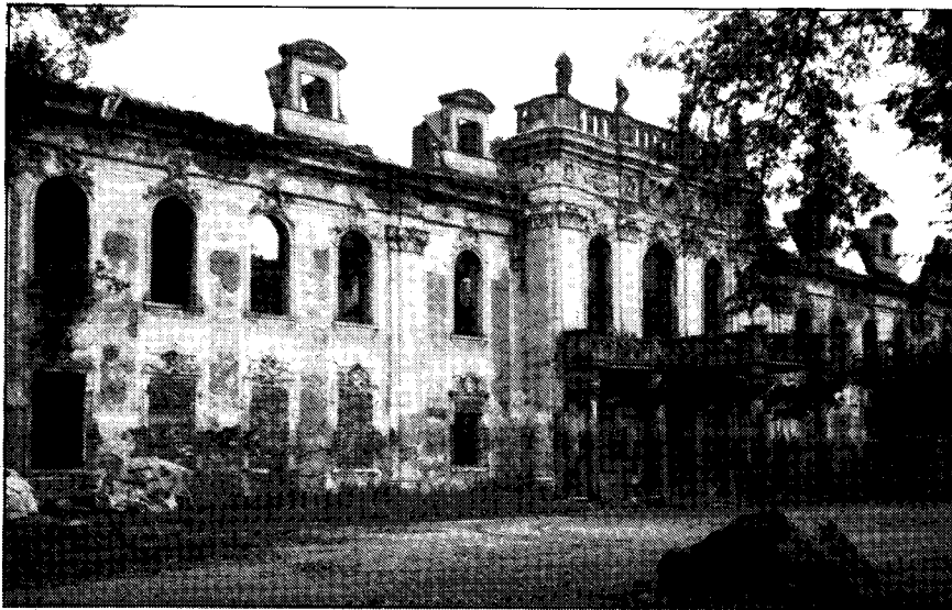
Ruine Schloß Goschütz. Frontalansicht. – (Foto Koenig)
