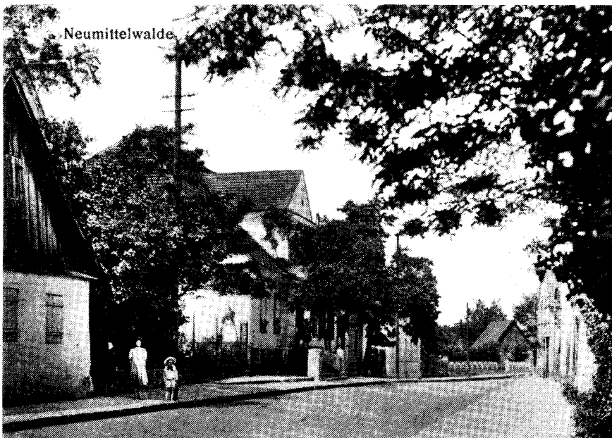
Die Bahnhofstraße. Eine Postkarte die noch aus der Buchhandlung Bronislawa Badura in Neumittelwalde stammt. (Später C. Eichhorn). Links das Heintke-Haus, Dr. Paul, Pluntke, und nach dem Zaun vom Amtsgericht sieht man noch das kleine Haus von Schütz. Auf der rechten Seite erkennt man den Ladeneingang von Büsser.
