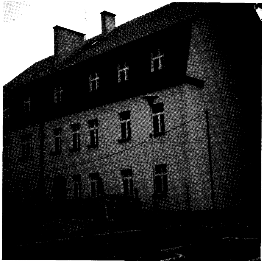
Umbau und Aufstockung der alten Festenberger Mittelschule (Vorderansicht).
