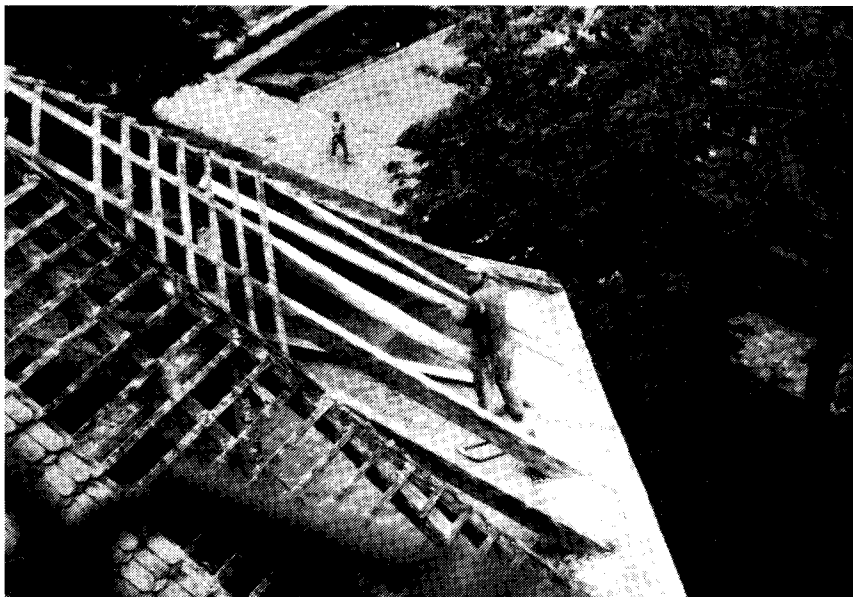
Arbeiten am Dach der Kirche über dem Altarraum an der Ostseite. – Foto: Reiss
