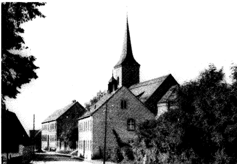
Der Gesamtkomplex Kirche, Pfarrwohnhaus mit Schule und Schwesternhaus St.-Joseph-Stift
